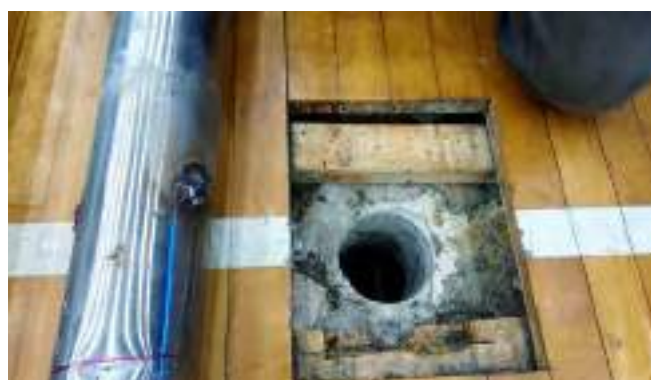
臺北體育館整修排球柱孔槽
