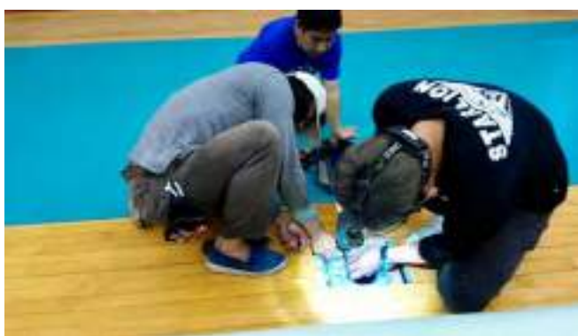
臺北體育館整修排球柱孔槽
